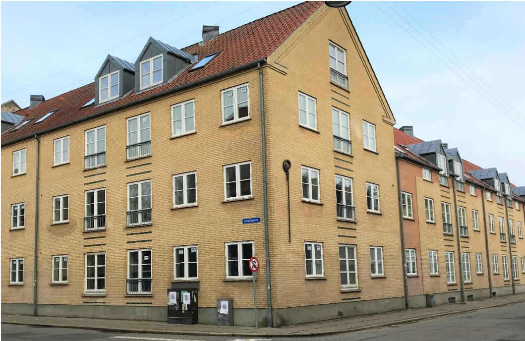
Eksempel på ny facade på Vivaboligs nye stayboliger for studerende.
